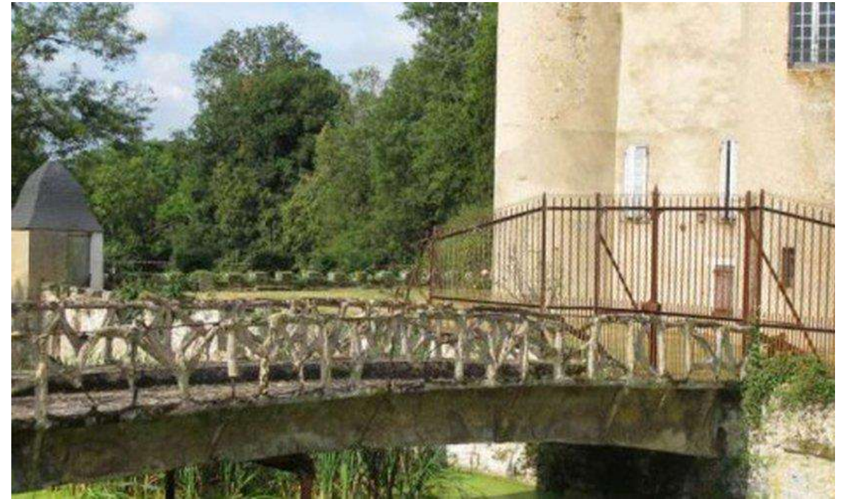
Premier pont en béton armé château de Chazelet -1875
